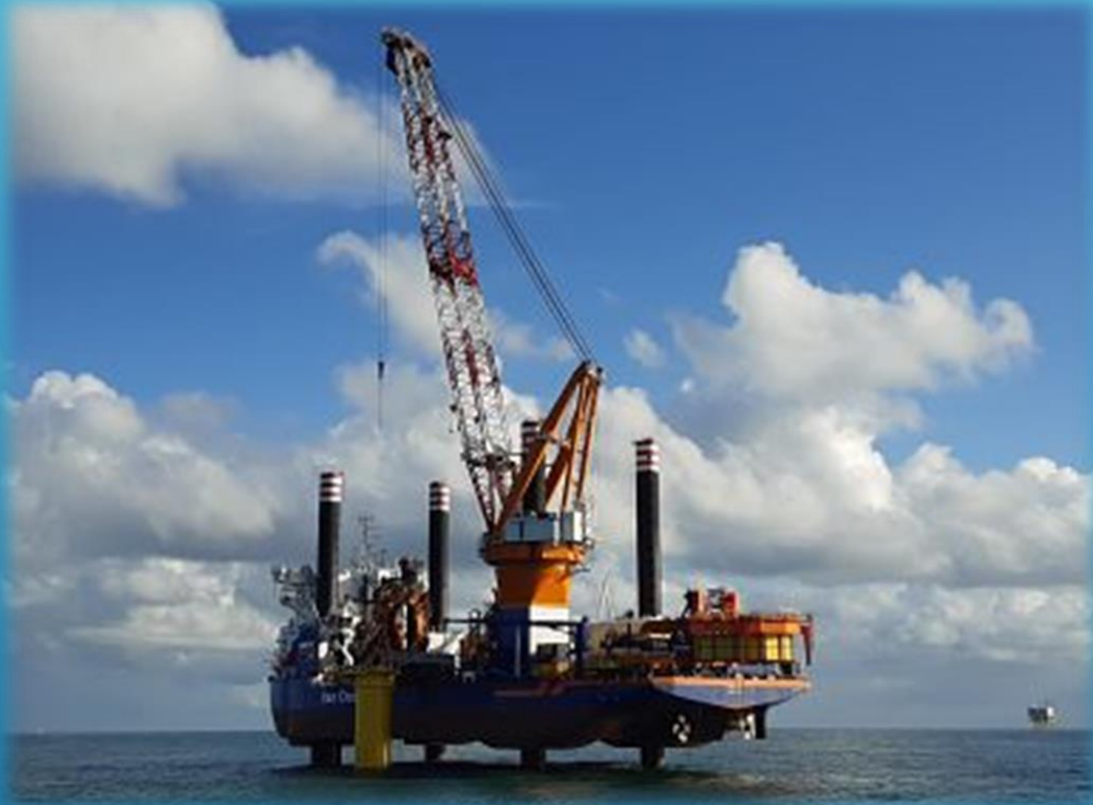
Forage pieux d'éoliennes (Ailes marines)
