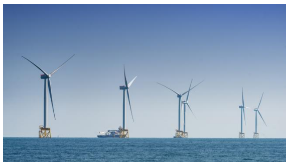
Parc éolien (crédit : Ailes marines)
